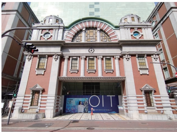
写真1 大阪工業大学 片岡安メモリアルゲート（写真1及び写真2は、いずれも北川撮影。片岡安メモリアルゲートの後ろの7号館は、記事作成の時点で、解体工事中のため、緑色のカバーがかけられています）
