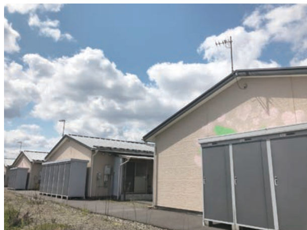
写真6 被災者向けの仮設住宅
