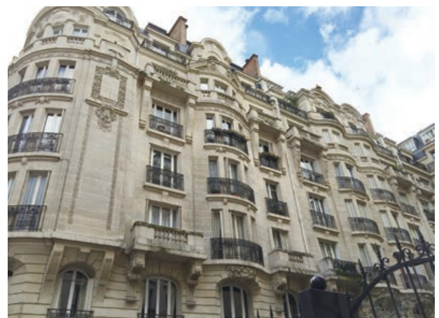
写真4 筆者の住んでいたアパートの外観
