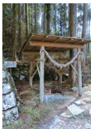
岩村城内の井戸（霧ヶ井）
