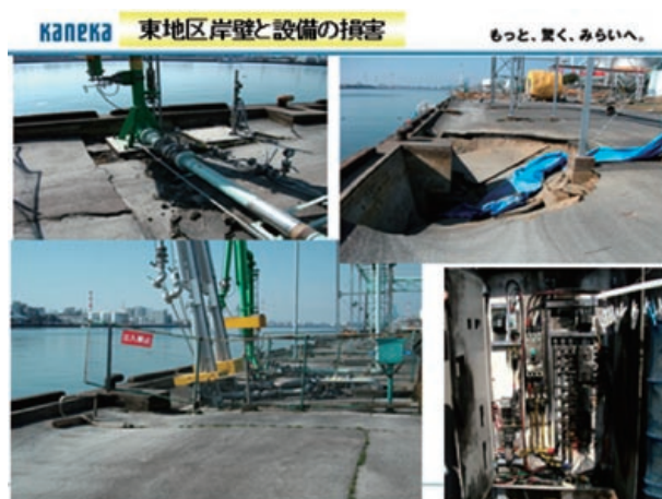
図14 東地区岸壁と設備の損害状況
