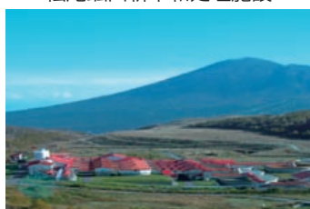
松尾鉱山新中和処理施設
