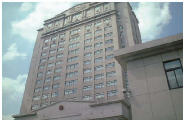
上海市第二中级人民法院の外観
