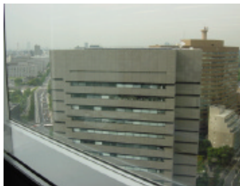
写真2 JTビルのオフィスから本庁舎を臨む 審査部とつかず離れず。緊張感と業務効率の バランスを考慮しました。
